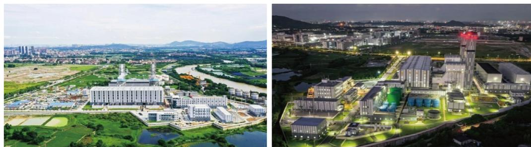
广东粤电花都天然气热电有限公司2×460MW级燃气-蒸汽热电联产项目，采用9F级改进型先进技术，各项经济指标和技术性能均处于国内领先水平，作为广州市中北部的的主要支撑电源之一，其建成投产为当地经济可持续发展提供绿色清洁能源保障。
