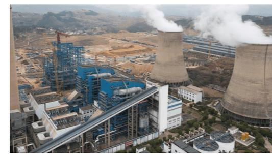
云南能投红河电厂采用国内最先进的超超临界循环流化床（CFB）发电技术，全厂热效率46.50%，供电标煤耗281.73克/千瓦时，机组灵活性高，在全国同类机组中处于领先水平。项目建成后，红河电厂“一大两小”机组总装机将达1300MW，可实现年发电量70亿千瓦时以上，成为滇南地区最大的稳定电源支撑点，对保障云南省能源安全具有重要意义。
