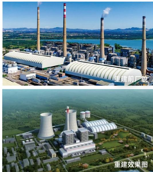
大唐国际陡河热电位于河北省唐山市开平区，始建于1973年，先后经历了震后重建和扩建，到1987年全部建成投产，是当时全国最大火力发电厂。本次拆除1-4号机组，在原厂址上新建2×660MW国产超超临界燃煤热电联产湿冷汽轮发电机组，被列为河北省、唐山市“十四五规划重大项目”和“重点建设项目”。
