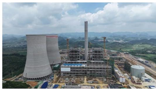
盘江普定燃煤发电项目是“十四五”期间省级重大工程和重点项目之一，由贵州能源集团所属企业筹资建设，总投资约52亿元，规划建设2台66万千瓦超超临界二次再热燃煤发电机组，按超低排放标准同步建设脱硫、脱硝及除尘设施，配套建设铁路货场专用线。项目建成后，将形成“一厂三区”工业产业布局，形成多条资源循环综合利用产业链，打造全省资源循环利用高效示范工业园区，为做大贵州电源规模、增强贵州电力供给能力、构建贵州电力能源保障体系发挥积极作用，对助推地方工业发展和区域经济发展、推动贵州经济社会发展具有重要意义。
