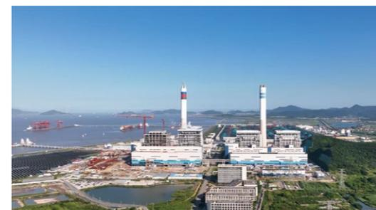
2024年7月10日16点17分，浙能六横电厂二期工程3号机组顺利投运。浙能六横二期位于舟山市六横岛，是浙江省首个应用二次再热及海水脱硫技术的百万千瓦级超超临界燃煤发电机组，浙江省“十四五”重大建设项目、“千项万亿”工程、“绿保稳”工程。项目总投资约66亿元，共建设2台1000MW燃煤发电机组，建成后每年可发电110亿千瓦时。
