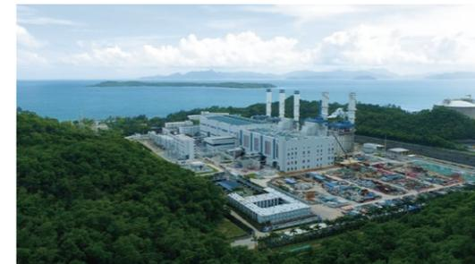
位于深圳市大鹏新区大鹏街道下沙秤头角，本次二期工程建设2台H级燃气-蒸汽联合循环发电机组。三期预留3台H级燃气-蒸汽联合循环发电机组的扩建条件，总规划容量约为5000MW。项目建成后将满足深圳地区电力负荷增长需求，有利于优化全市电源结构，提高电网系统调峰能力及供电的可靠性，为粤港澳大湾区的建设注入强劲动力。
