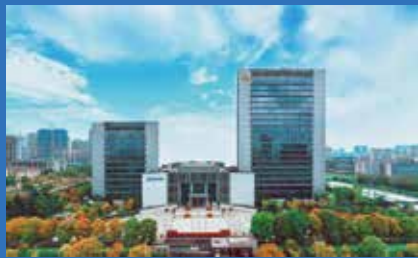
马鞍山钢铁股份有限公司
